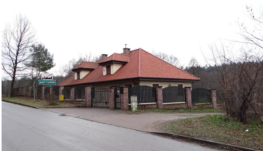
Zdjęcie nr 4. Obszar opracowania – w bezpośrednim sąsiedztwie analizowanego terenu widoczna zabudowa mieszkaniowa jednorodzinna.
